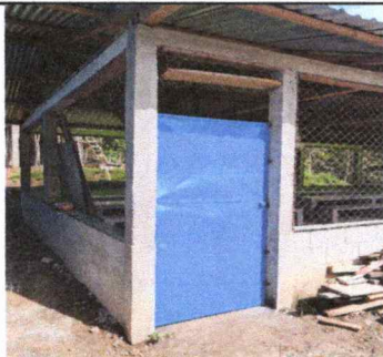
Foto 7: comedor y cocina con su respectiva puerta remozada.
