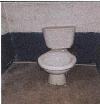
Foto1: Los baños remozados del establecimiento.
